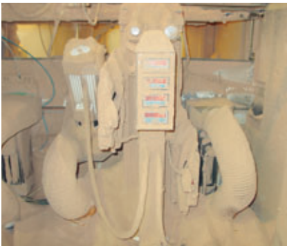
Usinage de revêtements de sols stratifiés, amoncellement typique de copeaux.
